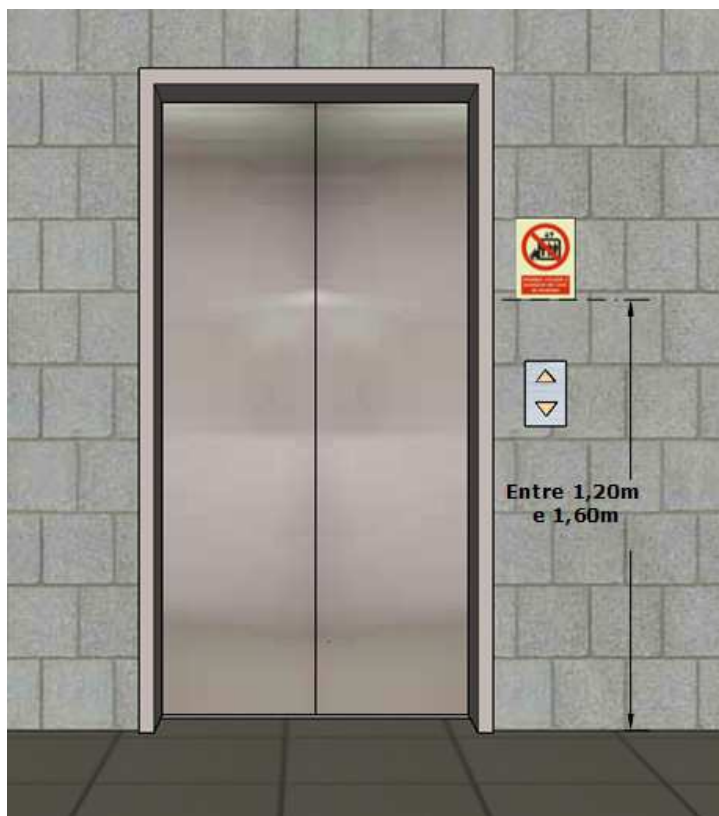
Imagem 09 – Sinalização básica de proibido utilizar elevador em caso de incêndio. (ver sinalização de código P4)
